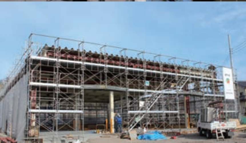
完成間近の集出荷貯蔵施設(本所敷地内)
