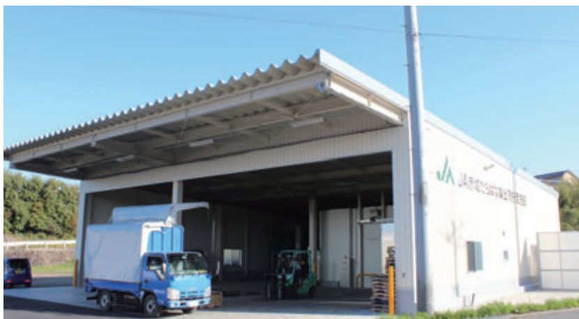
完成した集出荷貯蔵施設(本所敷地内)
