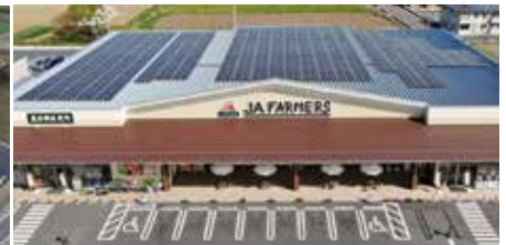
JAファーマーズへの自家消費型の太陽光パネル設置
