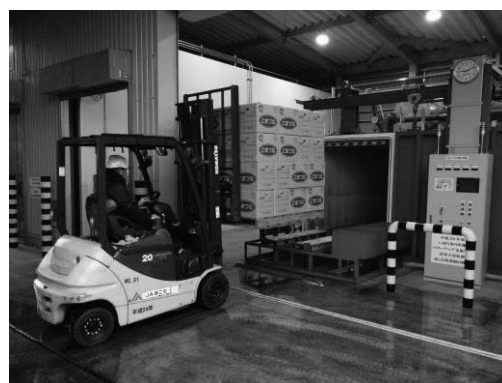
真空予冷施設
