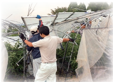
台風15号による災害復旧支援 (H27.8月 豊後大野市)
