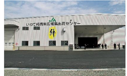
いわて純情米広域集出荷センター「絆」
