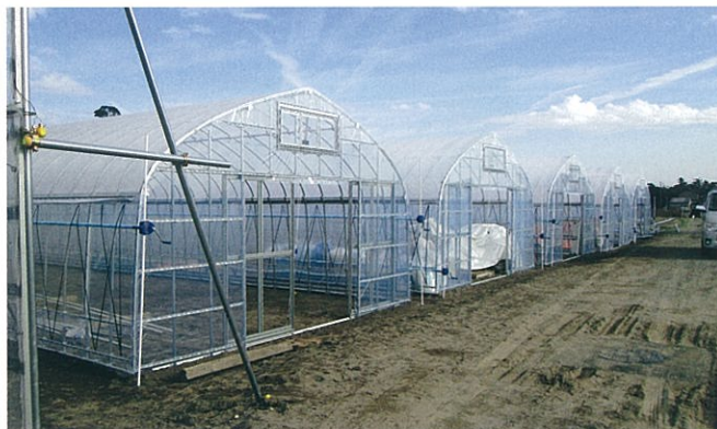
建設中のハウス団地
