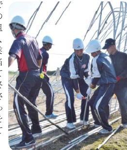
▲折れ曲がったビニールハウスの骨組みを運び出す野球部員の皆さん
