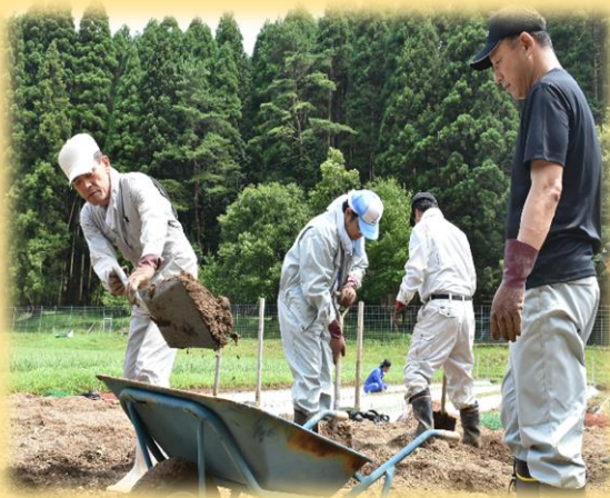
九州北部豪雨による災害復旧支援 (H29. 7月 日田市)
