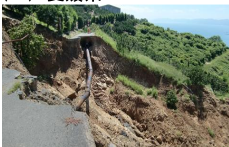
土砂崩れによりパイプが剥き出しになった園地
