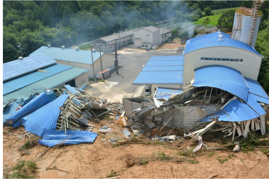
西日本豪雨で発生した土砂崩れにより大きな被害を受けた広島県内のJAのカントリーエレベーター
