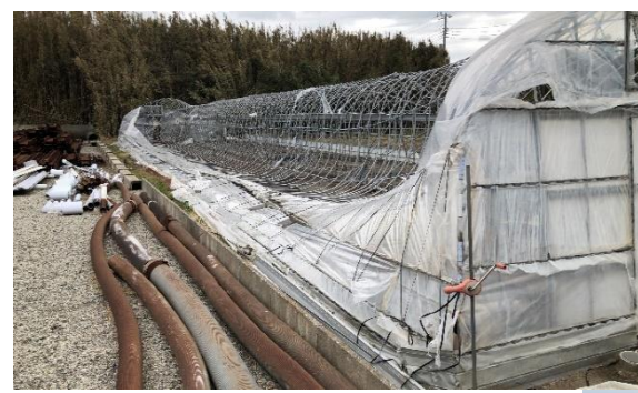
上写真: 台風15号の強風により倒壊したパイプハウス (千葉県内)
